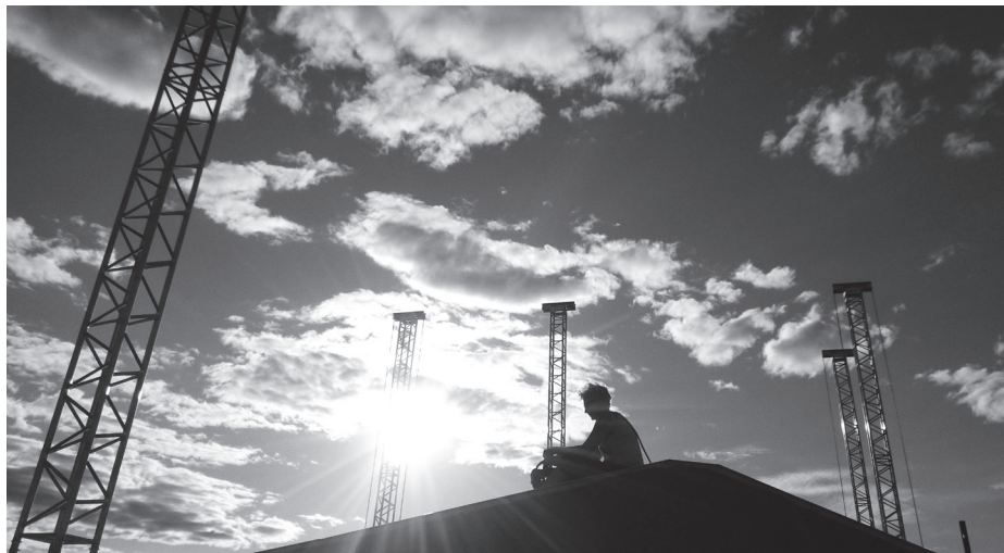
Photo : Toit en LT, usine d'Aku, Finlande
